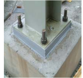
После снятия опалубки (на следующий день)
